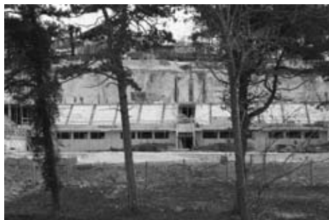
Neue Halle von Poreč (im Bau)
